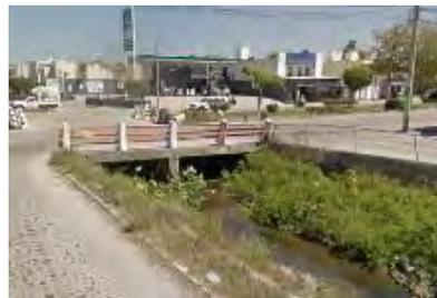
Reduccion de area hidraulica en Puente canal Palma areka
