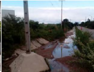
Estructuras que reducen el area hidraulica del Canal Tamarindos
